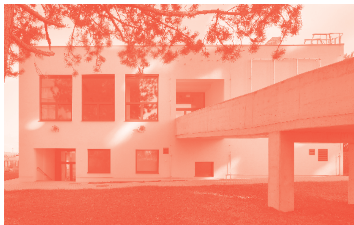
Pohled na DUÚL, vstupní rampa
